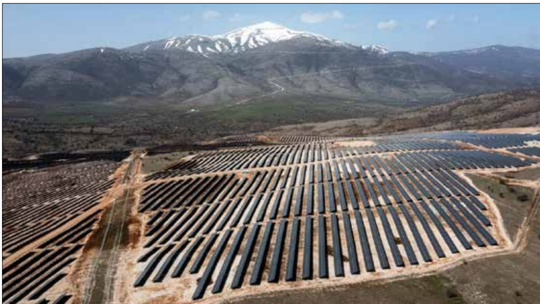
117. ábra – Befektetés a jövőbe: Napelemfarm a nyugat-makedóniai Kozani közelében. A 2022 áprilisában átadott létesítmény Európa legnagyobb olyan napelemfarmja, ahol a félmillió darab panel mindkét oldala áramot termel, és amely 75.000 háztartás éves elektromosáram-ellátását képes biztosítani. Görögország hasonlóan nagy hangsúlyt fektet a szélenergia kiaknázására is. A cél az, hogy 2030-ra a megújuló forrásokat felhasználó energiatermelés az ország energiaszükségletének 35%-át fedezze.
